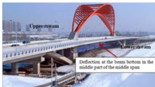
图 1. 伊通河桥主梁
